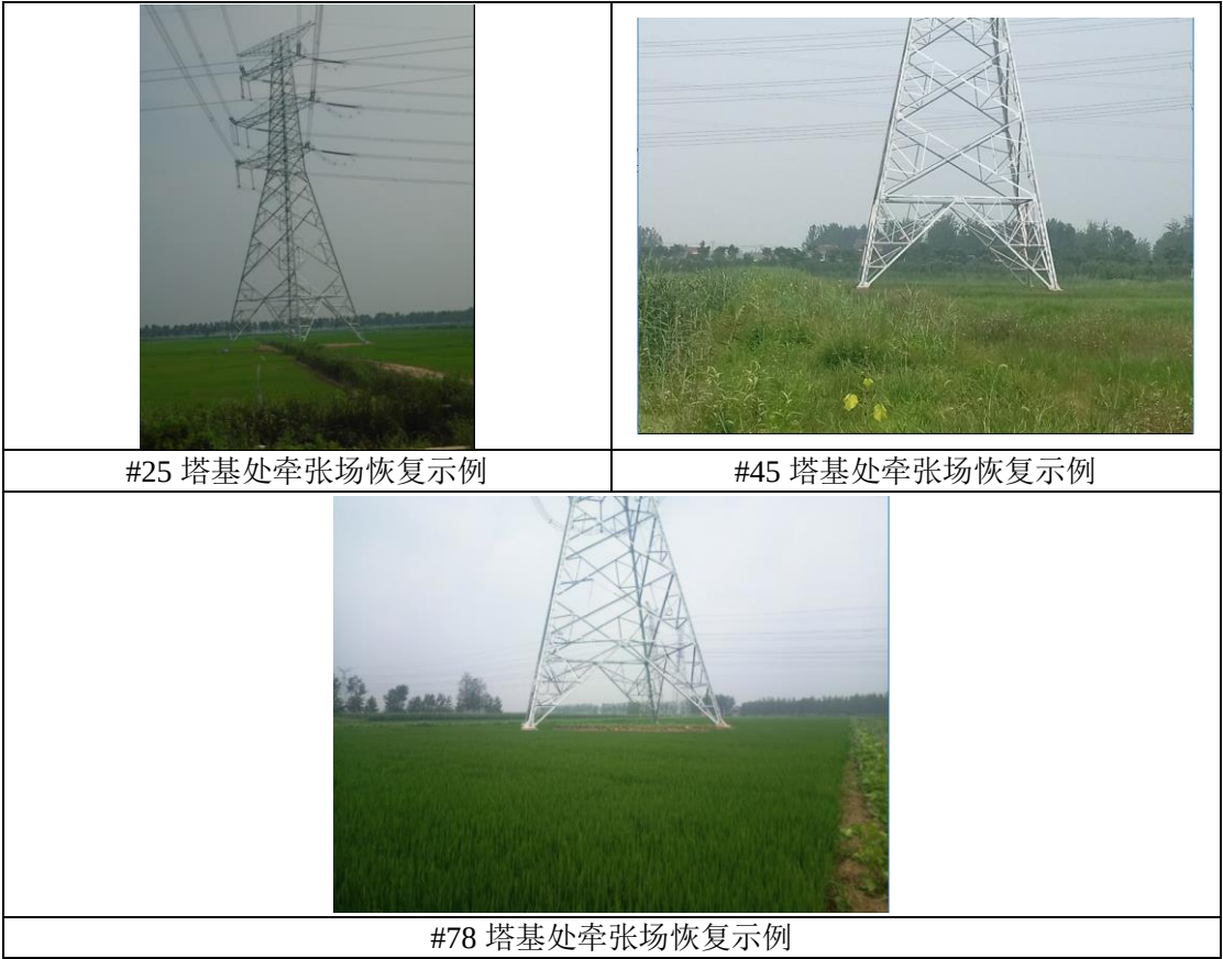
图 6-2 500kV 月滨 5K11/月响 5K12 线牵张场恢复示例
