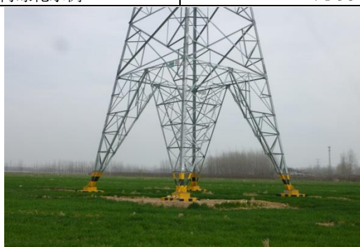
220kV 姚九 2640/九平 4E71 线#43 杆塔塔基生态恢复示例
