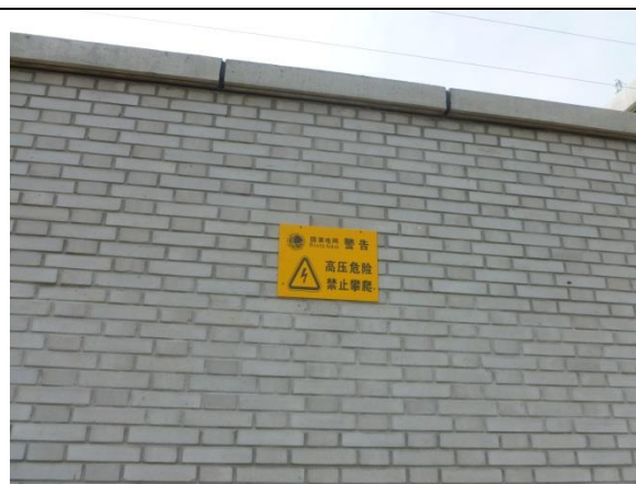
220kV 九墩变围墙安全警示示例
