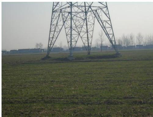
220kV 兴庆 4E03/4E04 线#76/#78 塔基恢复照片
