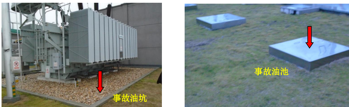
图 6-2 220kV 铁云变电站事故油池（坑）
