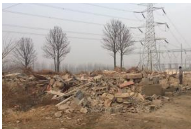
图 11-1 民房拆除现状图
