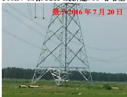
图 6-4 500kV 线路新建段牵张场恢复示例
