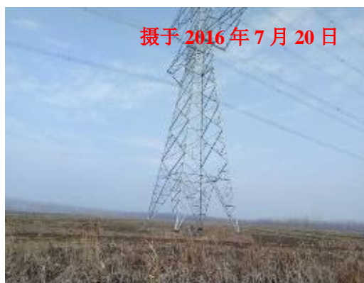
图 6-2 500kV 徐盐 5290 线新建#2 塔塔基恢复示例
