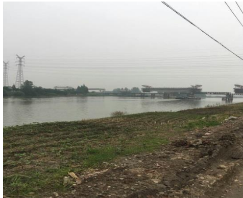
110kV 马杨 793/马牵 798 线跨越卤汀河时生态恢复示例
