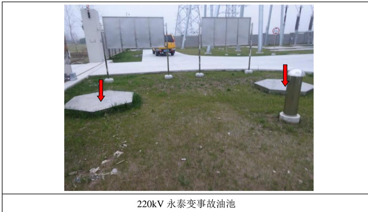
图 6-2 本批验收 220kV 永泰变电站事故油池照片
