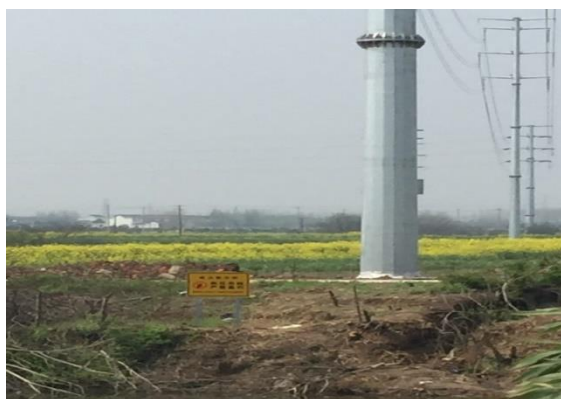
图 8-2 110kV 凤方 7LC 线安全警示标志示例
