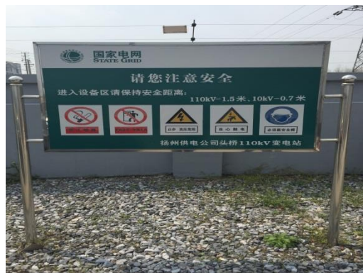
8-2 变电站安全警示标志示例
