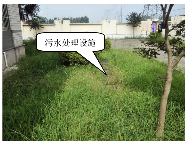
图 9-1 地埋式污水处理设施
