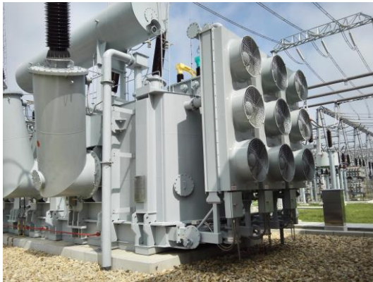
图 10-2 主变下方事故油坑
