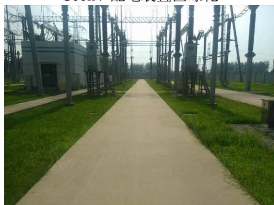
站内道路硬化
