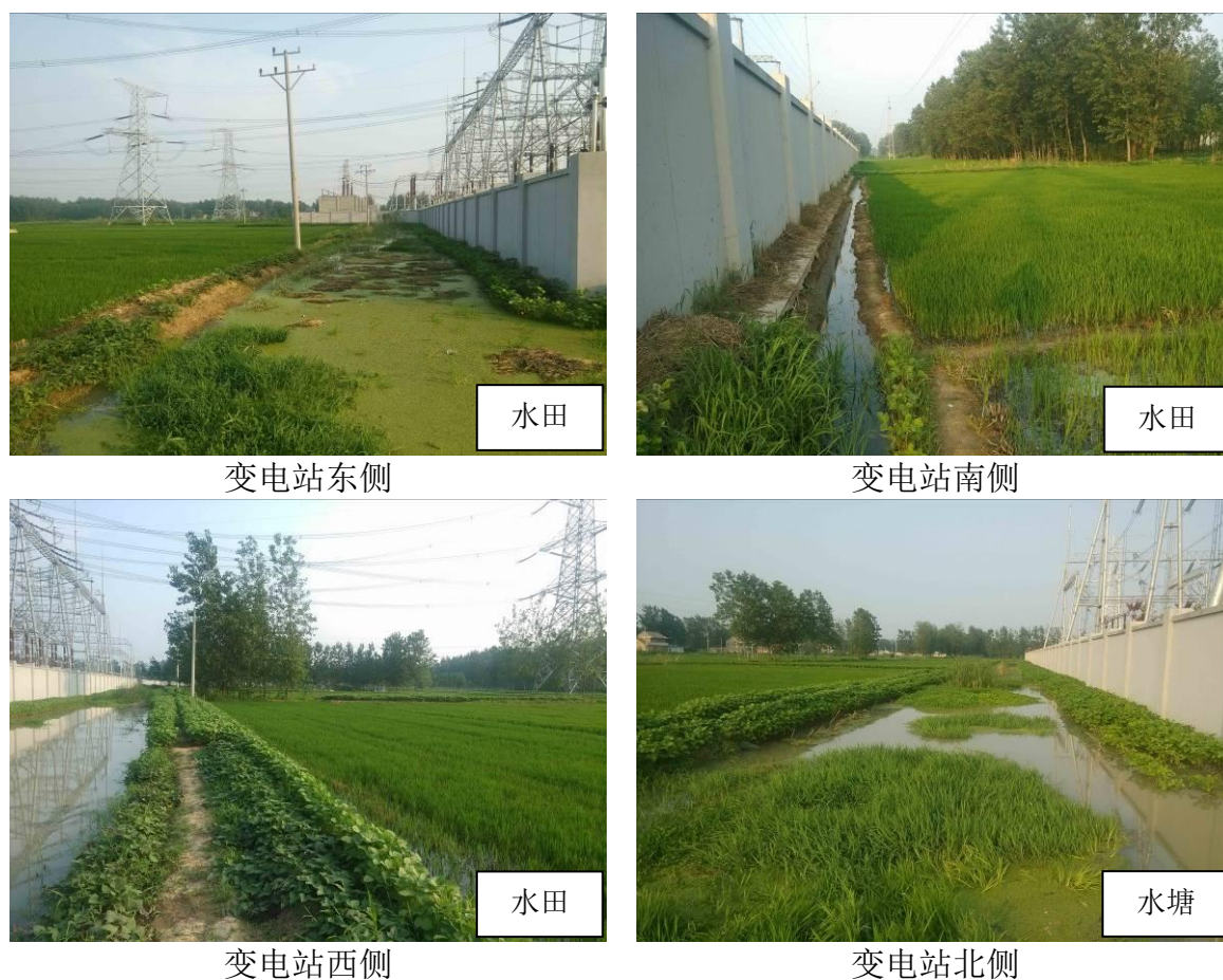
图 6.1 潘荡 500kV 变电站站址四周环境现状
