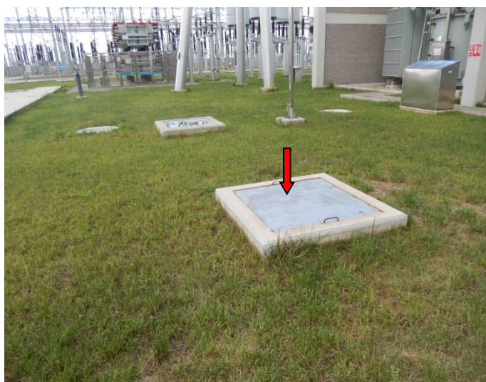
图 12-3 500kV 双草变电站现有总事故油池
