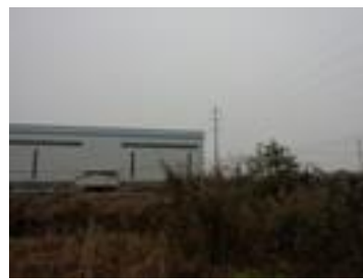
220kV 六圩变西侧生态恢复情况
