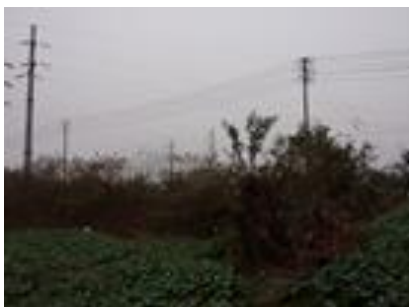
220kV 六圩变南侧生态恢复情况
