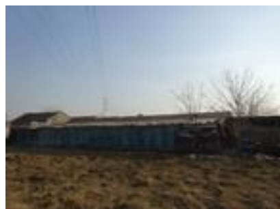
220kV 凤来变北侧生态恢复情况
