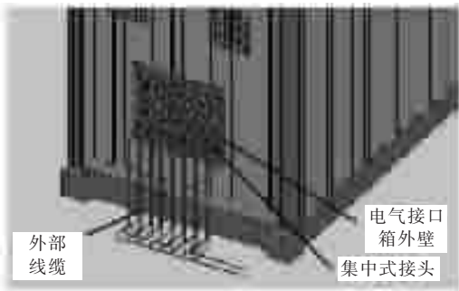
图 4 外部线缆从预制舱侧板接入
