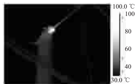
图 12 某 220 kV 刀闸 C 相刀口发热
