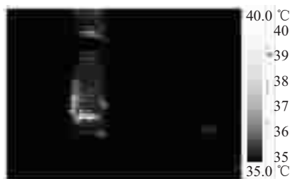
图 8 某电压互感器表面污秽致热
