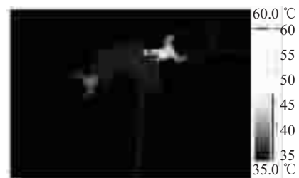
图 7 某 500 kV 电流互感器 C 相发热缺陷
