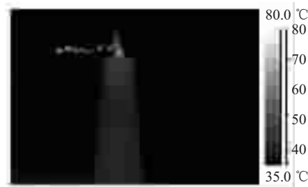
图 1 某电厂 2 号主变 B 相
