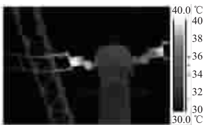
图 5 某 500 kV 电流互感器 C 相发热成像
